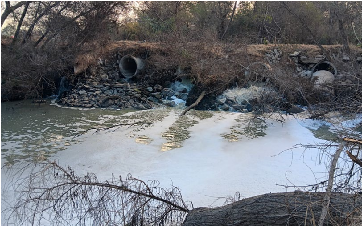
Existing Culverts at Saturn Tubería existentes en Saturno
