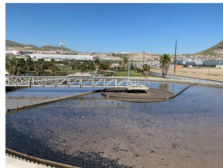
La Morita WWTP
