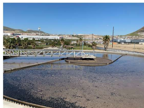
La Morita WWTP
